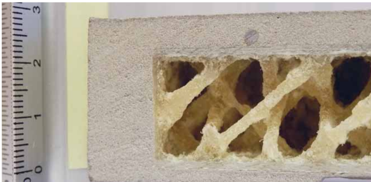
© Nouveau système constructif pour laboratoire en préfabriqué
